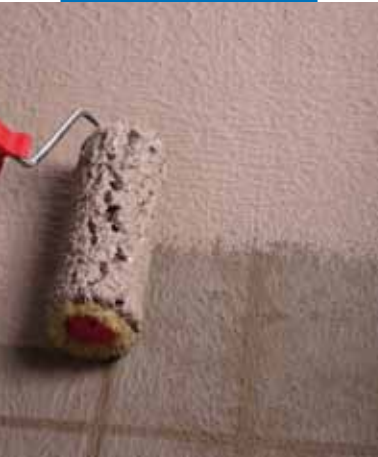
Provádění hydroizolace terasy válečkem
