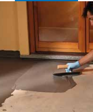
Provádění hydroizolace terasy hladítkem
