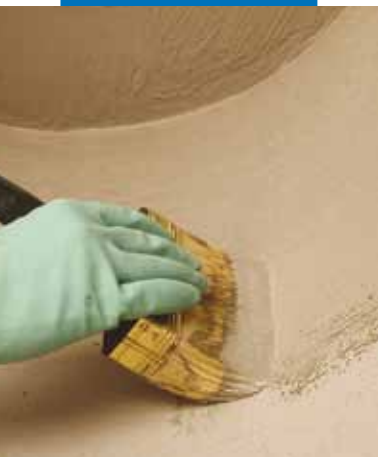
Provádění hydroizolace štětcem
